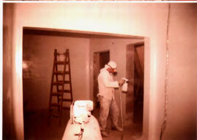
Fotos obras de reforma no HSA
