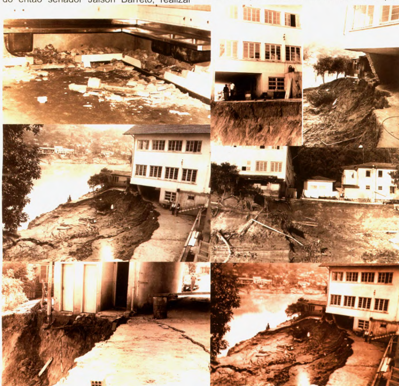
Destruição causada no HSA pela enchente de 1983
