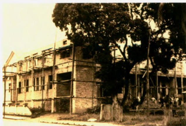
Construção do Hospital Santo Antônio em 1944, após demolição do antigo, que estava em ruínas.
