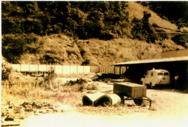
Vista da colocação de um muro pré-fabricado e galpão no depósito da rua Itajaí
