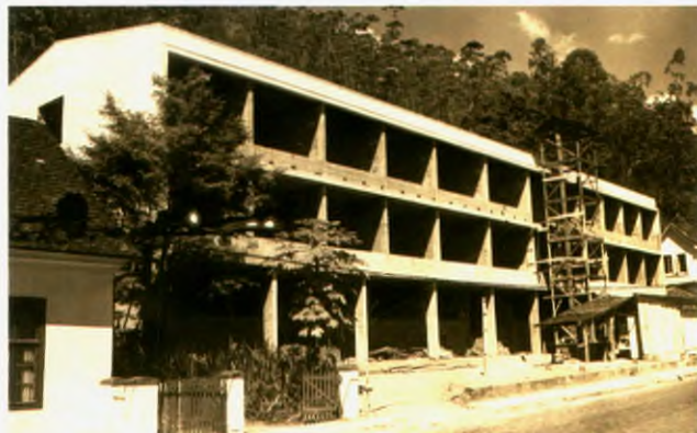
Obra de construção do Pavilhão Infantil do hospital. Governo de Hercílio Deeke, 1965.
