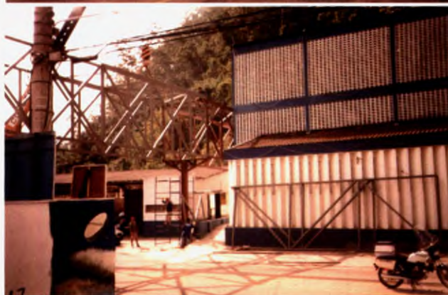
Passarela em construção
