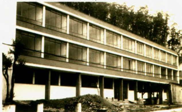
Obras do Hospital Santo Antônio
