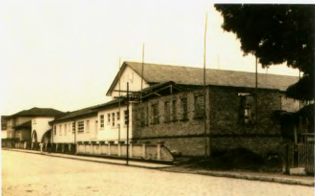
Hospital Santo Antônio em construção
