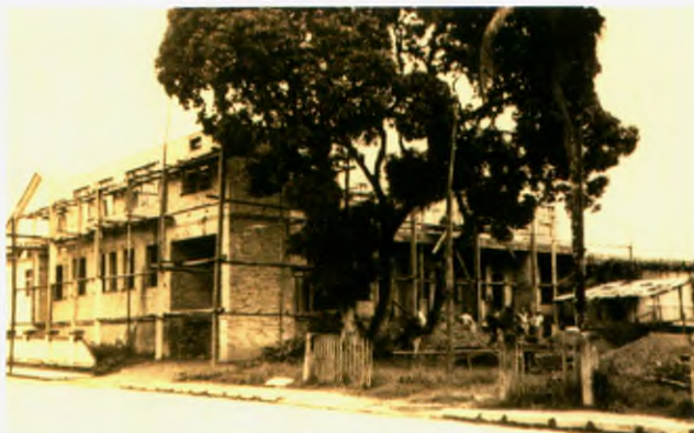
Construção de novas estruturas do Hospital Santo Antônio
