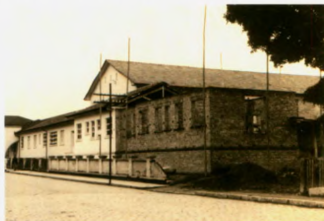
Construção das novas áreas do Hospital Santo Antônio como Maternidade e Pediatria, em junho de 1953.
