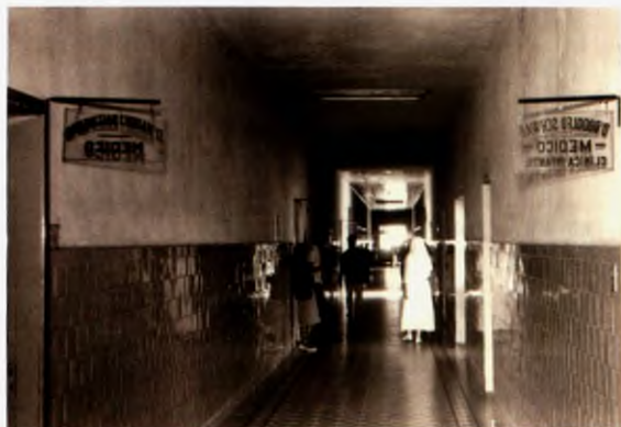
Corredor onde ficavam os consultórios médicos do hospital
